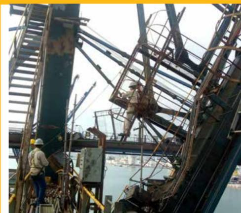
[TNG] Una excelente labor de equipo fue la que realizó en mayo el personal del Astillero al realizar el servicio de mantenimiento del tensor fracturado de las grúas QC-5 de ICAVE, lo cual incluyó trabajos de renovación de acero durante un lapso de 2 días.
